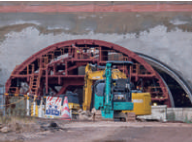
トンネル工事
